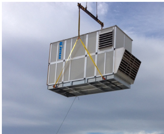
Unit die op het dak gehesen wordt.
